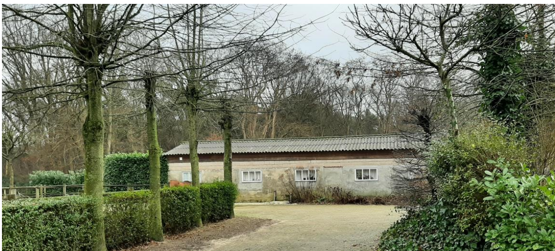
Afbeelding 6: Foto's huidige situatie westzijde van het bijgebouw
