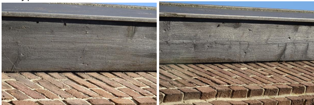
Afbeelding 7 en 8: openstaande overstek waar vleermuizen achter kunnen verblijven of in de bebouwing kunnen komen. Bron: BNL advies, datum: 23-03-2022
