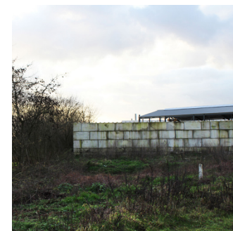
keerwand van legioblokken
