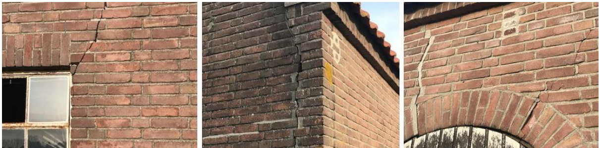
Impressie van de bouwkundige staat van het bijgebouw
