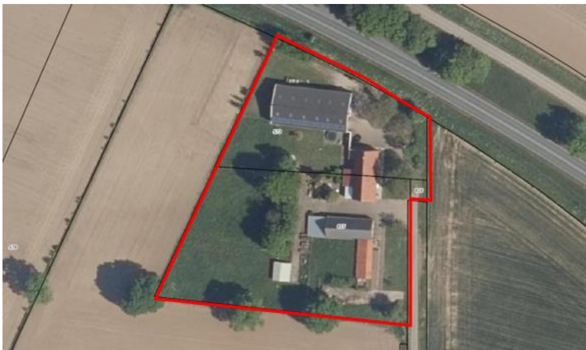
Luchtfoto van het plangebied (bron: ruimtelijkeplannen.nl)
